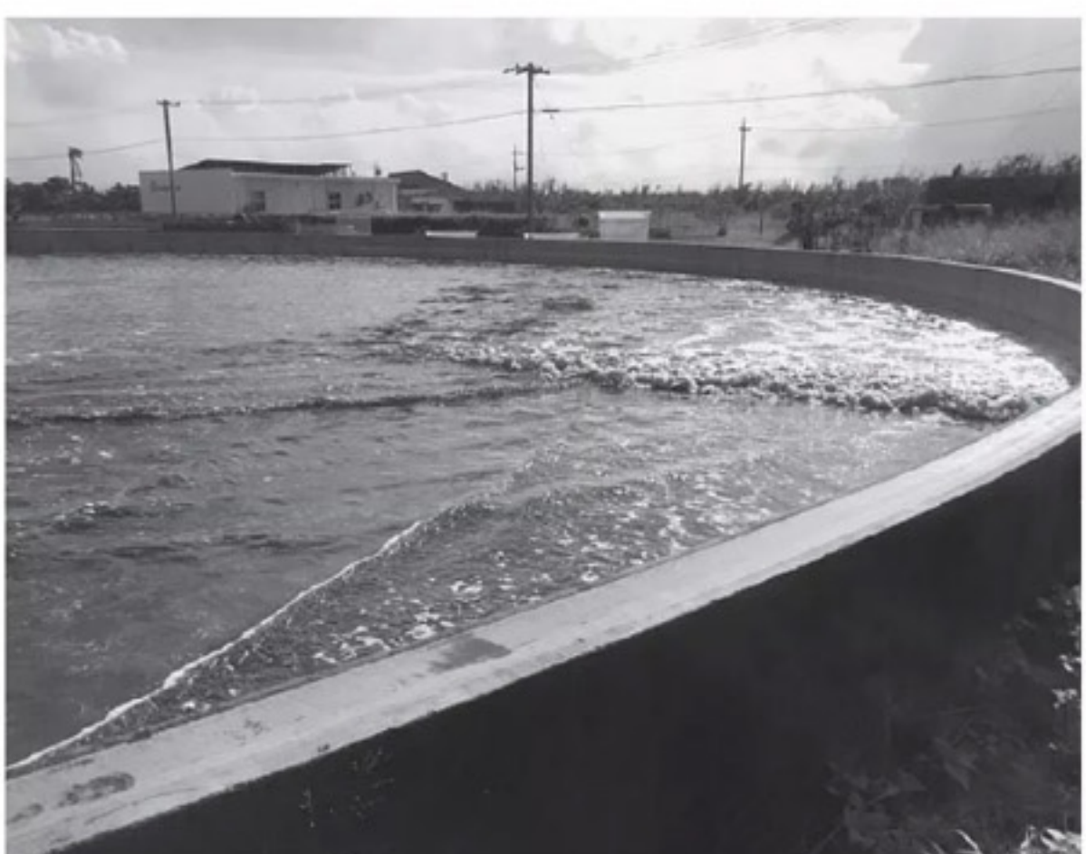
ユーグレナ社が沖縄県石垣島に建設したミドリムシの培養施設(上)。培養したミドリムシを粉末化するための「スプレードライヤー」と呼ばれる巨大な乾燥機(右)
